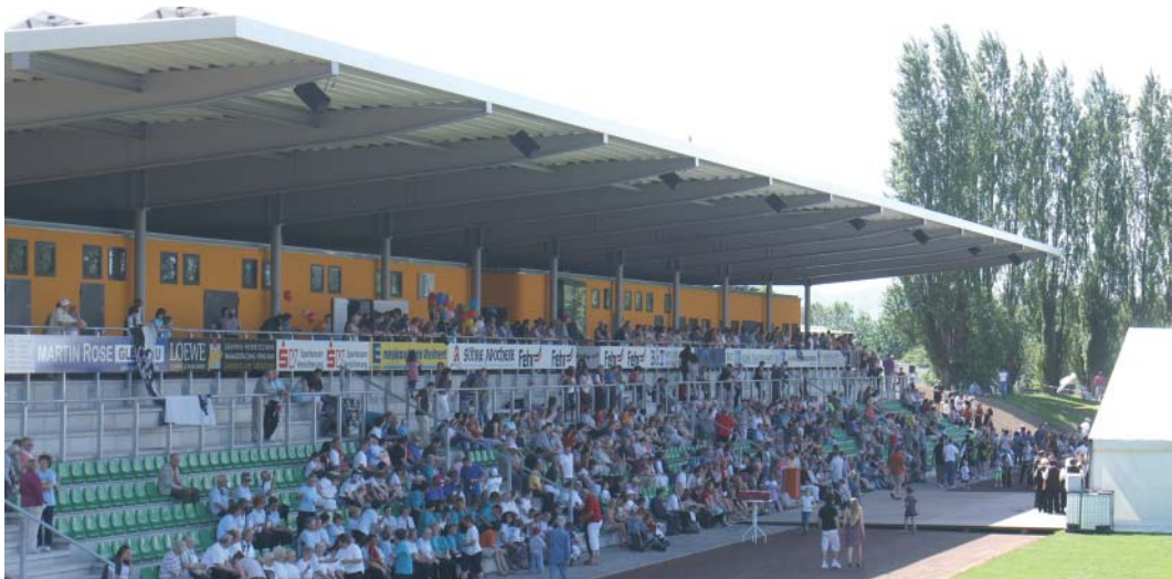
Das Nordhessenstadion erhielt neue Sportfunktionsräume und eine neue Tribüne.
