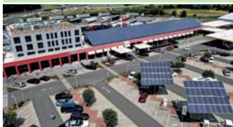
Blick auf das Interkommunale Gewerbegebiet „Am Lohfeldener Rüssel“ mit gleichnamiger Rastanlage.
