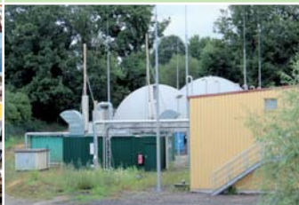
Biogasanlage in Vollmarshausen.
