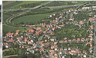
Blick auf den „Lohfeldener Rüssel“, der auf Luftaufnahmen deutlich zu erkennen ist.
