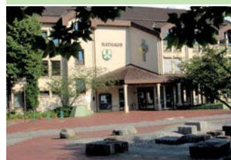
Das Lohfeldener Rathaus in der Langen Straße.
