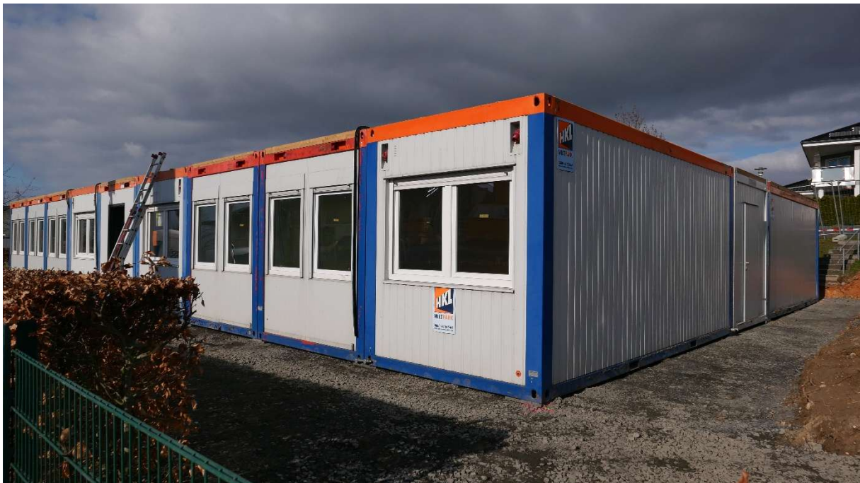
Ansicht von der Straße (Containeraufstellung 3/2021)
